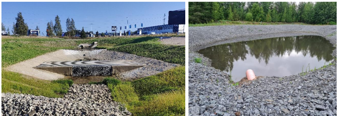
Kuva 4. Teollisuus- ja liikennöityjen alueiden hulevesien hallintarakenteet (vas.) ovat usein moniosaisia, sillä niissä yhdistyy hulevesien laadullinen ja määrällinen hallinta. Hulevesien imeytysrakenteilla (oik.) hallitaan tehokkaasti hulevesien laatua (kuvat Sitowise).
