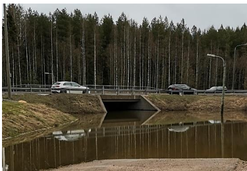
Kuva 1. Alikulut ovat herkkiä tulvimiselle, ja niiden kuivatus hoidetaan yleensä pumppaamalla. Hulevesi- ja purotulvat voivat aiheuttaa mm. katujen hetkellistä sulkemista (kuvat Sitowise).
