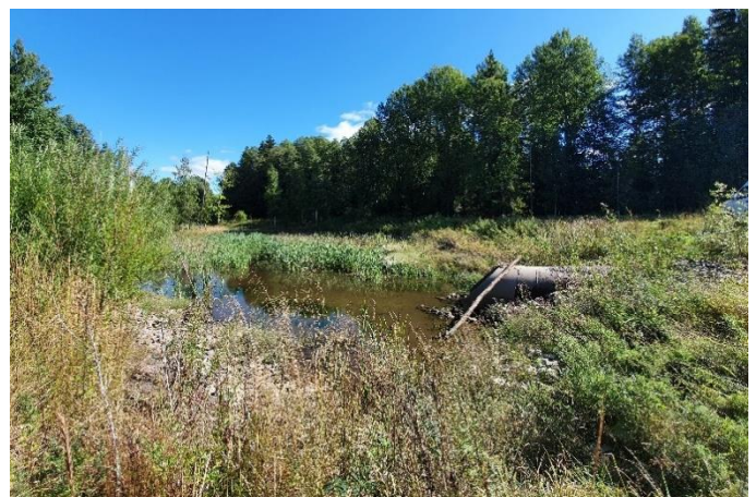
Kuva 3. Katualueelle rakennettu biosuodatuspainanne (vas.) vähentää sekä laadullista kuormitusta vastaanottaviin vesistöihin että hulevesitulvariskiä, kun hulevesiä hallitaan jo niiden syntypaikalla. Laajemman alueen hulevesien hallinnassa kosteikkorakenteet (oik.) ovat tehokkaita, ja ne voidaan toteuttaa luonnon monimuotoisuutta tukien (kuvat Sitowise).
