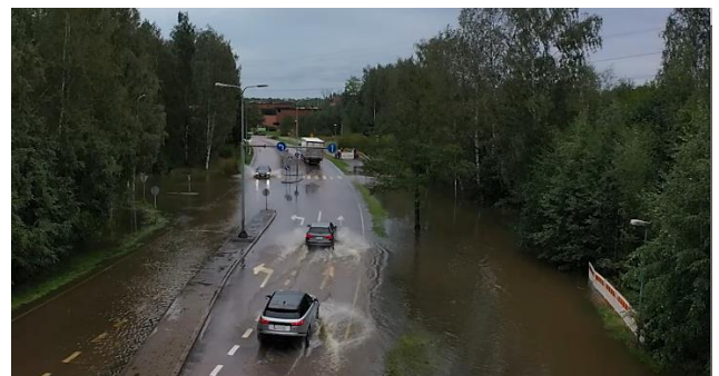
Kuva 1. Alikulut ovat herkkiä tulvimiselle, ja niiden kuivatus hoidetaan yleensä pumppaamalla. Hulevesi- ja purotulvat voivat aiheuttaa mm. katujen hetkellistä sulkemista (kuvat Sitowise).
