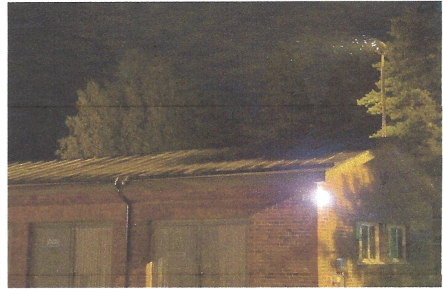
Kuva 6. Huoltoaukion keltavalolampuilla todettiin runsaasti hyönteisiä mutta ei lepakoita.
