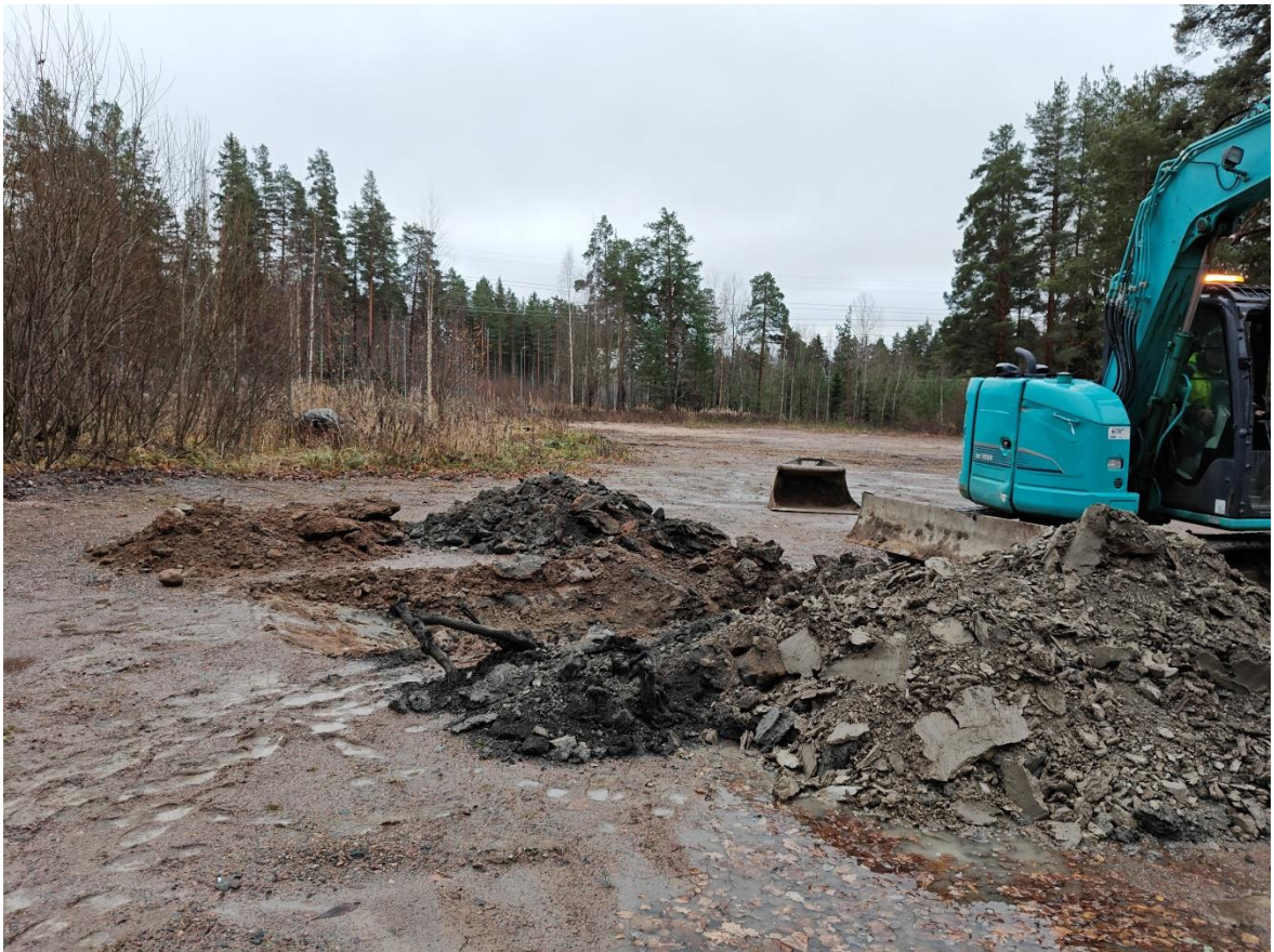
Kuva 7. Koekuopan KK7 kaivu käynnissä, kuvattu luoteesta.
