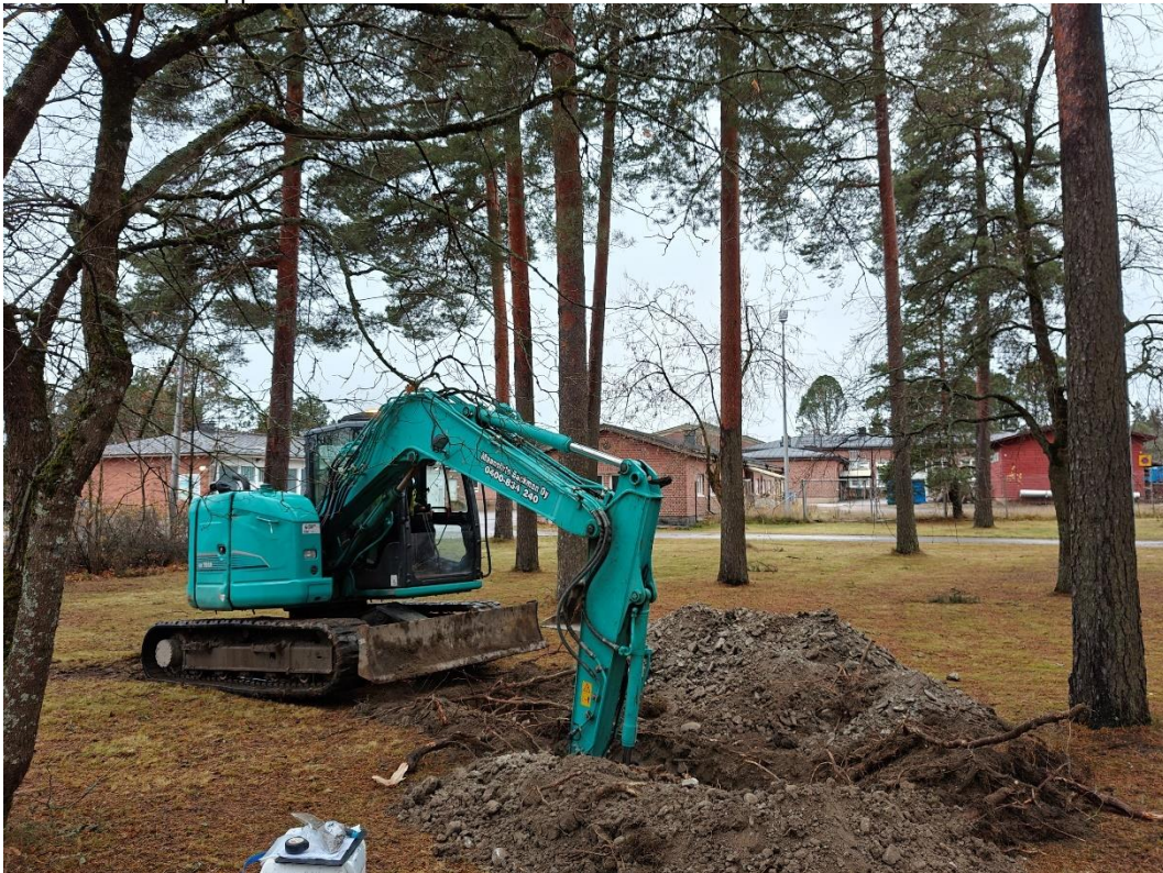
Kuva 4. Koekuopan KK4 kaivu käynnissä, kuvattu idästä.
