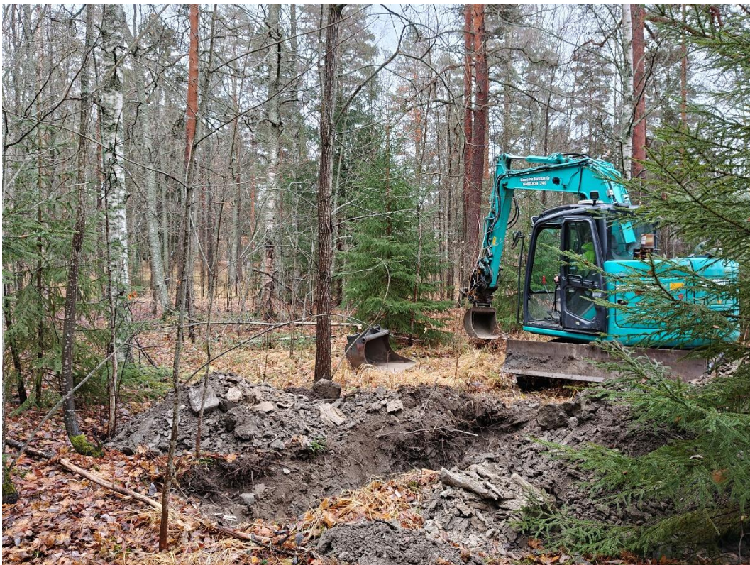
Kuva 2. Koekuopan KK2 kaivu käynnissä.
