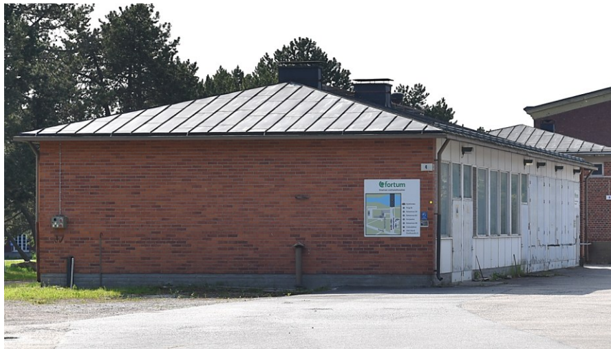
Kuva: Huoltorakennuksen pitkät sivut ovat sävyltään vaalea. Ovien yläpuolella vanhat seinävalaisimet (opaalikuoppa ja peltisuojuus).
