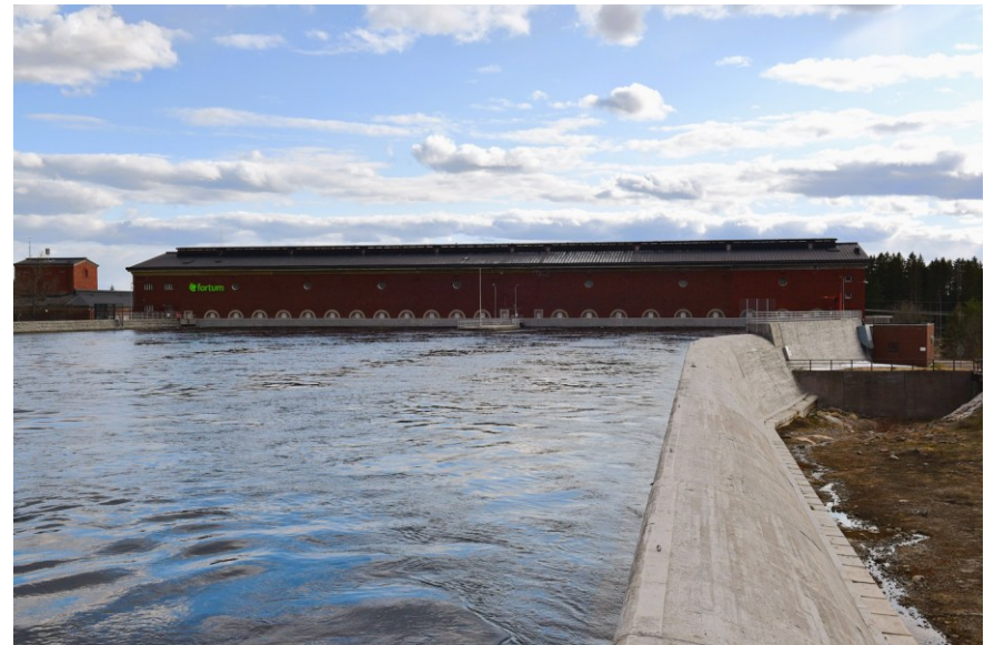
Kuva: Imatran koneasema- eli voima-asema Kanavasillan eteläpuolella.
