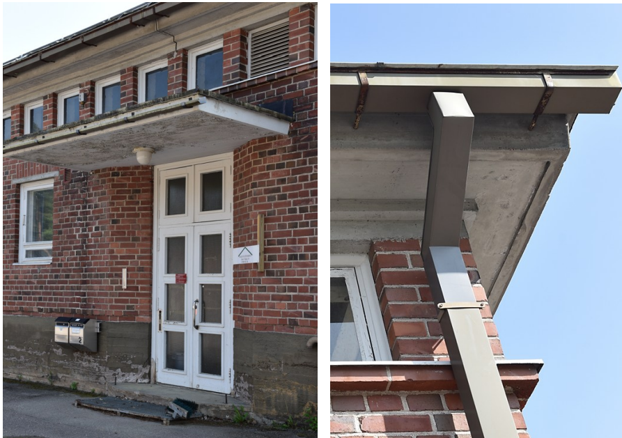
Kuvat: Varastorakennuksen vanha lasiaukollinen peiliovi ja viistetyt smyygit. Kaikissa kolmessa 30-luvun rakennuksissa on samanlainen betoniräystä.
