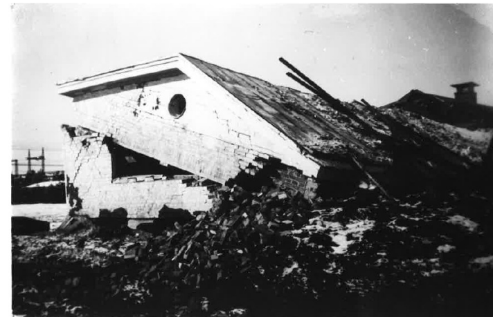
Kuva: Talvisodan pommitustuhoa voimalaitoksessa. Autotallirakennuksen kulmalle on osunut miinapommi. Rakennuksen itäosat on rakennettu uudelleen. / Fortum Oyj:n arkisto.
