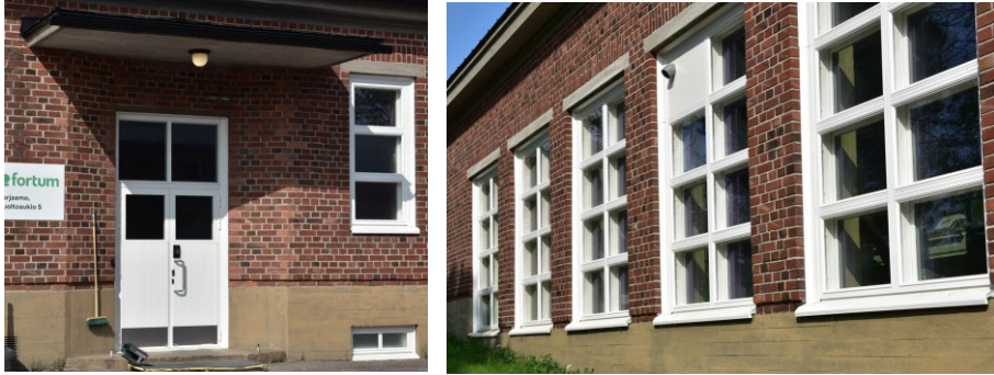
Kuvat: Korjaamon uusi pääovi tehtiin edellisen oven tyyliin. Oviaukon sivuilla on viisteet. Uudet ikkunat.
