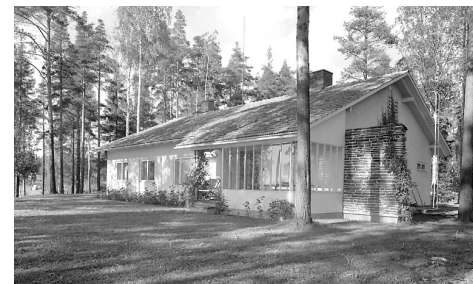
Kuva: Insinööritaloissa, jotka arkkitehtitoimisto Aarne Ervi suunnitteli 40-luvulla Imatran Voiman uudelle asuinalueelle, on samaa muodonantoa ja detaljointia kuin punatiilisen ruokalarakennuksen arkkitehtuurissa. / Mäkinen, Eino, valokuvaaja 1957, kesä-heinäkuu 1957.
