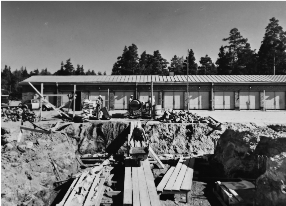
Kuva: Uuden huoltorakennuksen pohjatyöt käynnissä 12. elokuuta 1959. Taustalla autotallirakennus. Rakennuskortin tietojen mukaan ovien paneelit uusittiin 1970-luvulla. / Valokuvaamo Foto Roos. ELKA.
