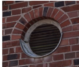
Kuva: 1934 tehty pyöreikkuna.
