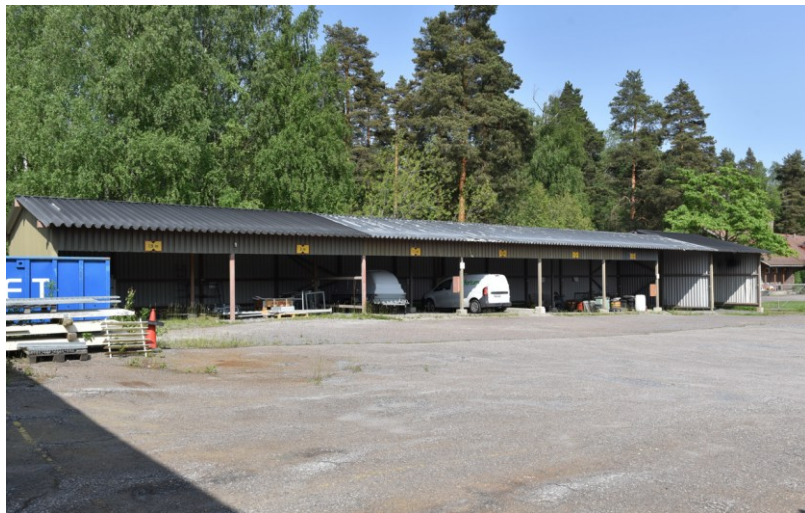
Kuva: Teräsrunkoinen autokatos 1981, laajennettu 1990-luvun alussa.
