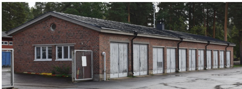
Kuva: Autotallin länsipääty ja julkisivu etelään.
