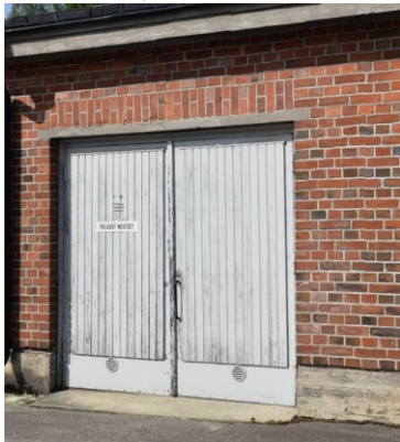
Kuva: Autotallin pystypaneeliovet.
