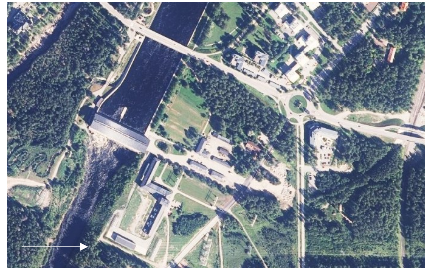
Kuva 4: Uusi sähköasema ja veistokselliset voimajohtorakenteet valmistuivat 2020 kytkinaseman eteläpuolella. / MML 2023 .
