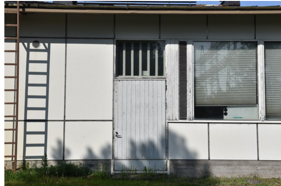
Kuva: Valkoiset peltistoin kiinnitetyt verhouslevyt ja isot nauhaikkunat muodostavat julkisivuihin ruutuaiheen, johon syntyy katkoksia ovien ja kamaikkunoiden pystylinjaisuudesta.
