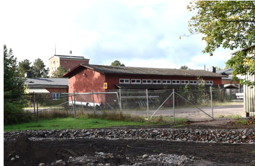
Kuva: Rautavarasto ja sen takana autotalli ja kytkinaseman torni. Etualalla on Voima-puron työmaa.
