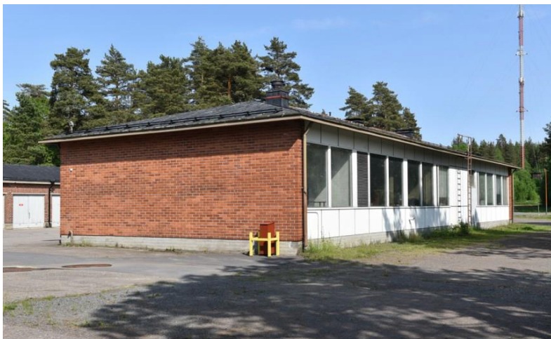
1960 Huoltorakennus, arkkitehtitoimisto Aarne Ervi
