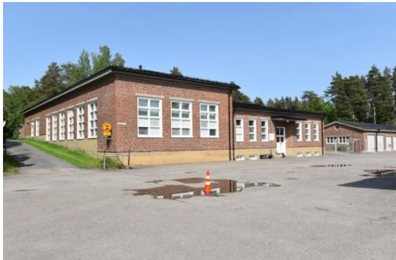
1938 Korjauspaja, rakennusmestari Emil Ekegren, IVO
