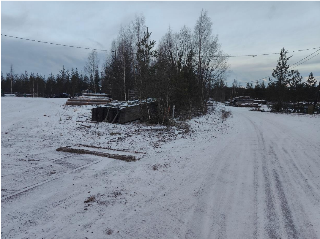
Kuva 2. Vesioronkankaan pohjavesialueelle – Kurkvuoren teollisuusalueelle - asennettiin 1 pohjavesiputki (YKN2405).
