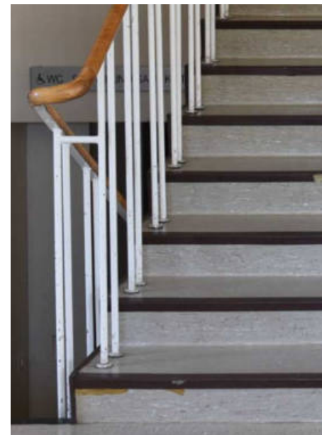
Kuva: Kirkkosalin porras: muovimatto ja lista. Kuva: Sivuportaan maalattu betonipinta.
