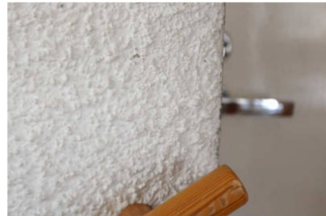
Kuva: Alttaripäädyn seinät, syvennystä lukuun ottamatta, on pinnoitettu karkealla rappauksella.
