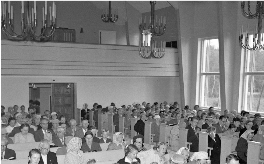
Kuva: Eteläseinän isoissa ikkunoissa oli yksi vaakavälikarmi ja puitteet olivat kolmijakoiset. / Valok. Lassi Sinkkonen 1957 . Kosken kuvaamon kokoelma, IKM.
