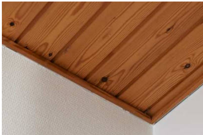
Kuva: Pääsisäänkäynnin tuulikaapin mäntypaneelikatto ja suorat kattolistat 1980-luvulta.
