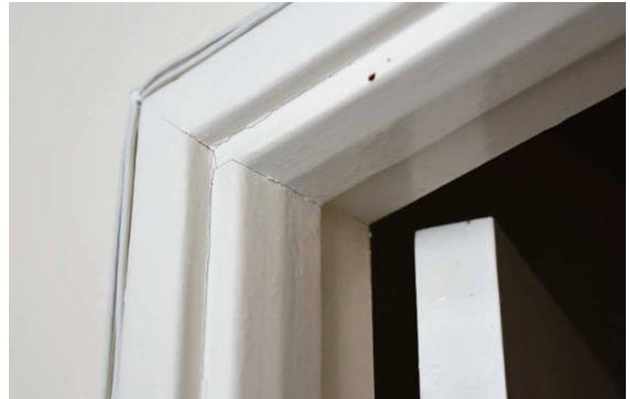
Kuva: Vanhoissa ovikarmeissa on keskitaite.
