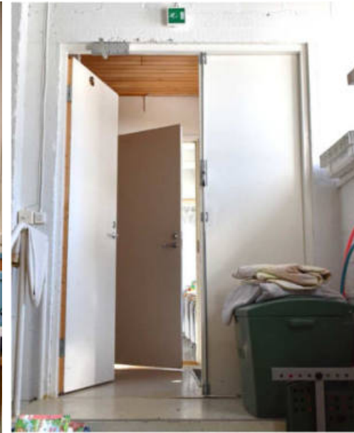
Kuva: Entistä kattilahuonetta.
