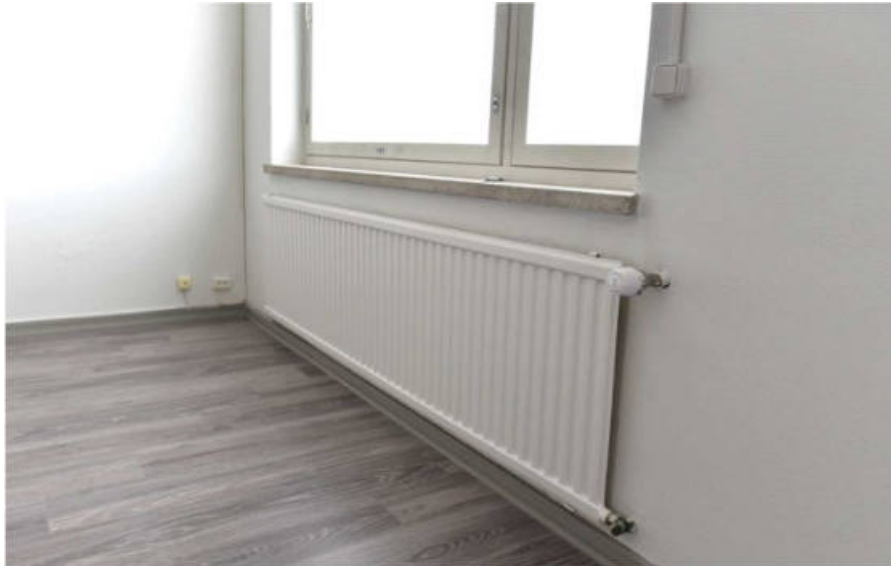
Kuva: Ikkunat on uusittu. Ikkunapenkki on mosaiikkibetonia. Lattiasa on laminaatti ja 1980-luvun patteri PURMO-mallistoa.
