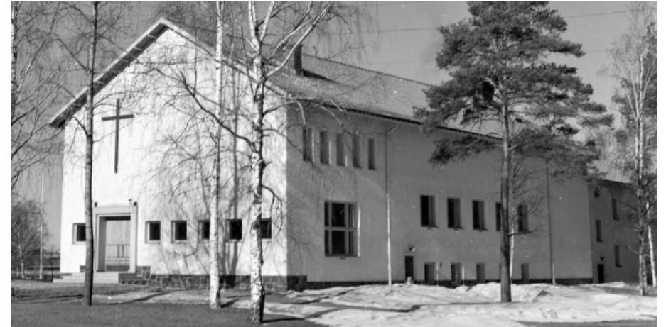
Kuva: Kuvassa erottuu pohjakerrokseen avautuva ovi (myöh. muurattu umpeen) sekä asuntupuolen ovi, jossa ei ole suojakatosta. Kirkkosalin ikkunat eivät ole keskijakoisia. / Valokuvaaja Kosken Kuvaamo 1958, EKM
