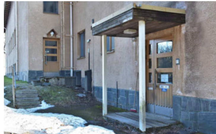
Kuva: Pohjoisen julkisivun vanhat sisäänkäynnit.
