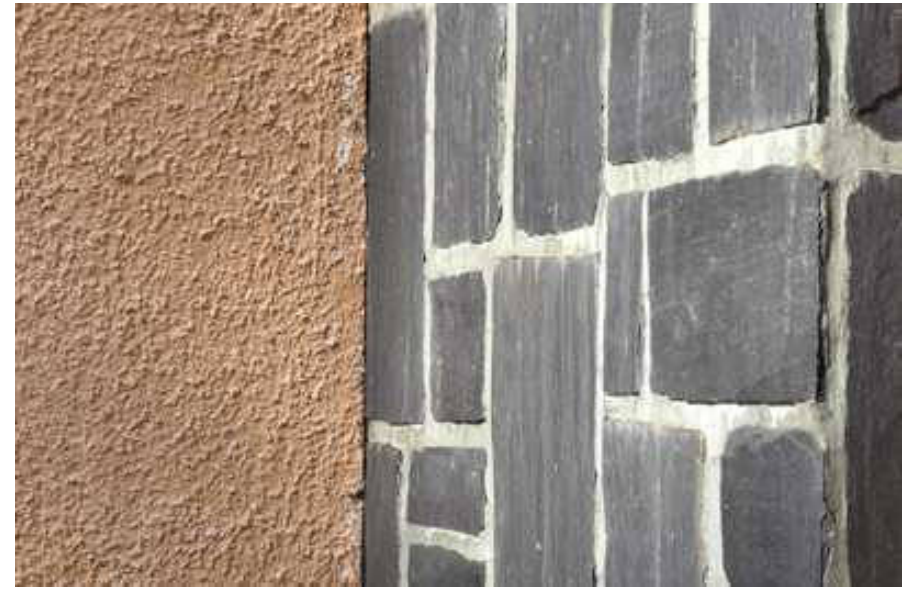
Kuva: Liuskekiviverhous on tehty säännöllisen muotoisista laatoista kuviomuurauksena.
