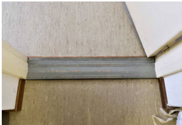
Kuva: Kirkkosalin ja peräseinän komeron muovimatot ja suorat matalat lattialistat. Ovenkarmissa keskitaite.
