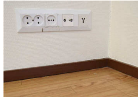
Kuva: Muovimatto on tavallisin lattiapäällyste. Suurin osa lattia- ja muista peitelistoista on malliltaan yksinkertaisia, suoria ja kapeita.
