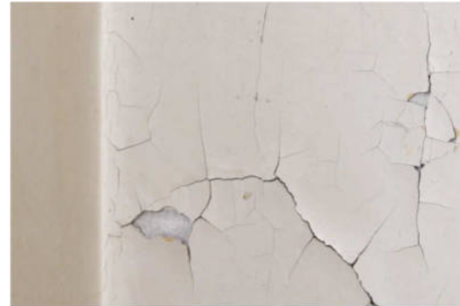
Kuva: Tiilimuuriseinässä on rappaus, tasoite ja maali.
