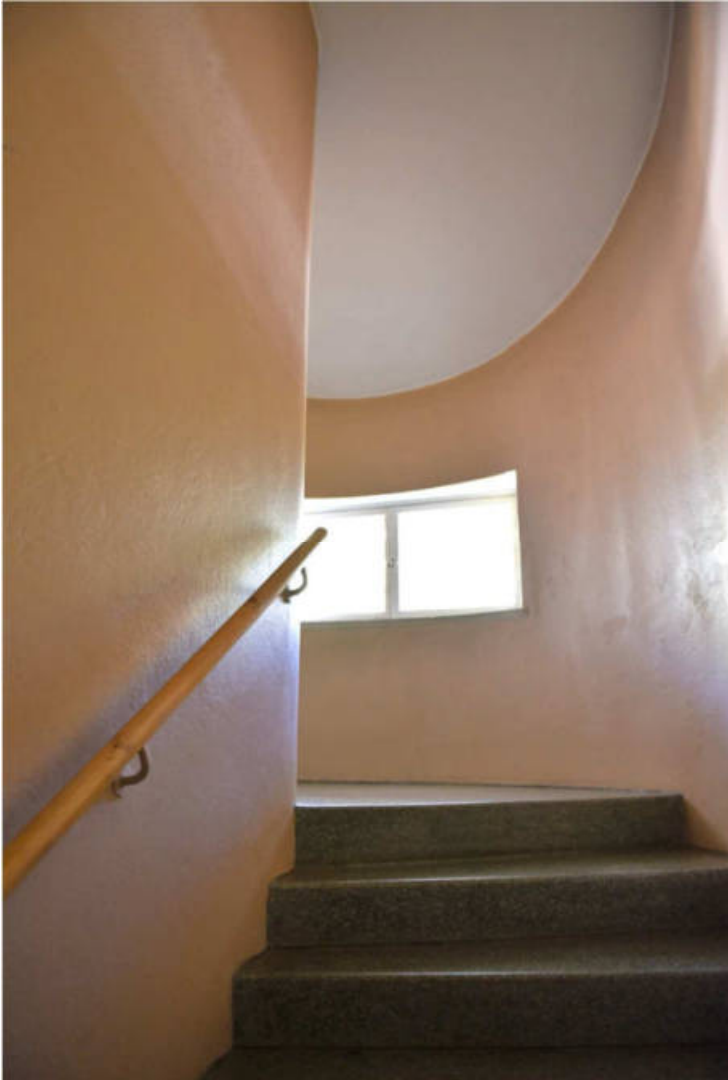
Kuva: Kaarevaseinäinen porrashuone, jossa kiertävä mosaiikkibetonipintainen porras lepotasantein. Seinään kiinnitetty käsijohde on pyöreä ja lakattu.
