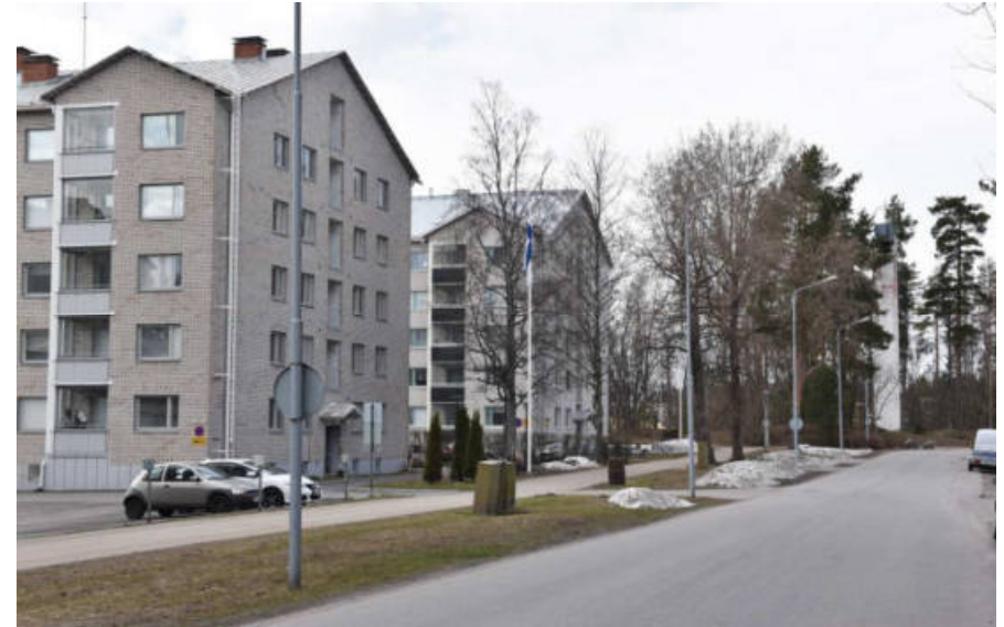
Kuva: Nykyään autoliikenne kirkolle kulkee Kanava-aukion kautta 50-luvulle perustetun kerrostalokorttelin ohi. Näiden V-kerroksisten pistetalojen rakennuttaminen oli kauppalan ensimmäisiä laajamittaisia rakennushankkeita. Kellotapuli näkyy kadun päässä.
