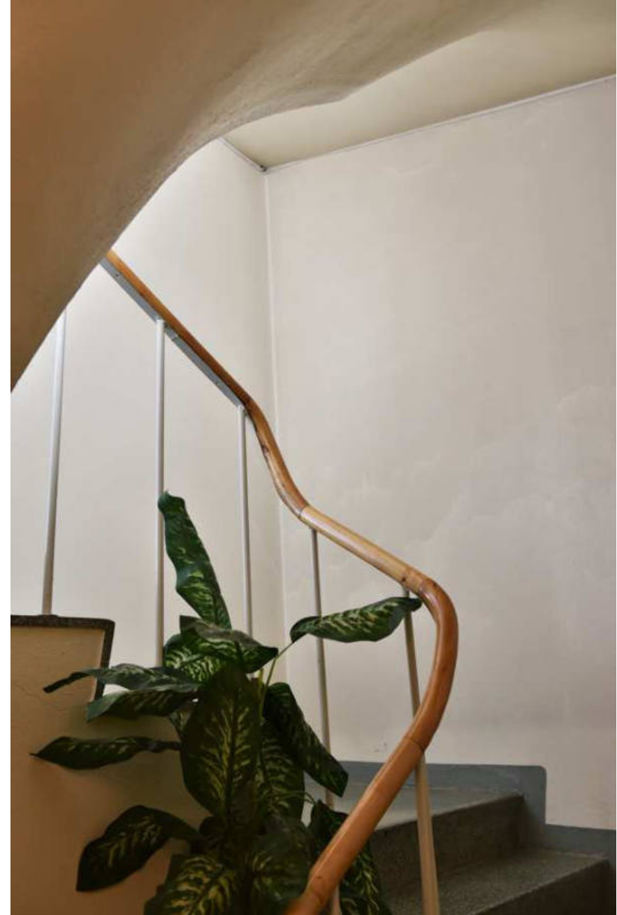
Kuva: Eteishallista vaatevarastoon vievä porras, jossa pehmeästi kaartuva puinen käsijohde ja metallipinnakaide. Kivimuuriseinien sisällä on säilynyt siroa käsityötä.
