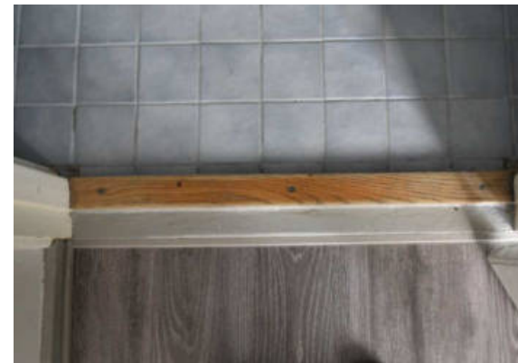
Kuva: 2000-luvun remonttien lattiapäällysteitä, laminaattia ja sinisiä laattoja.
