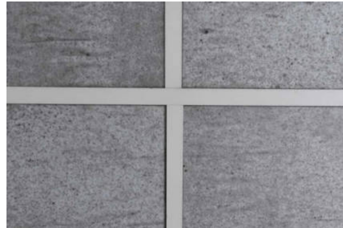
Kuva: Villalevyjä ja verhoulistoja sakastin katossa 1980-luvulta.
