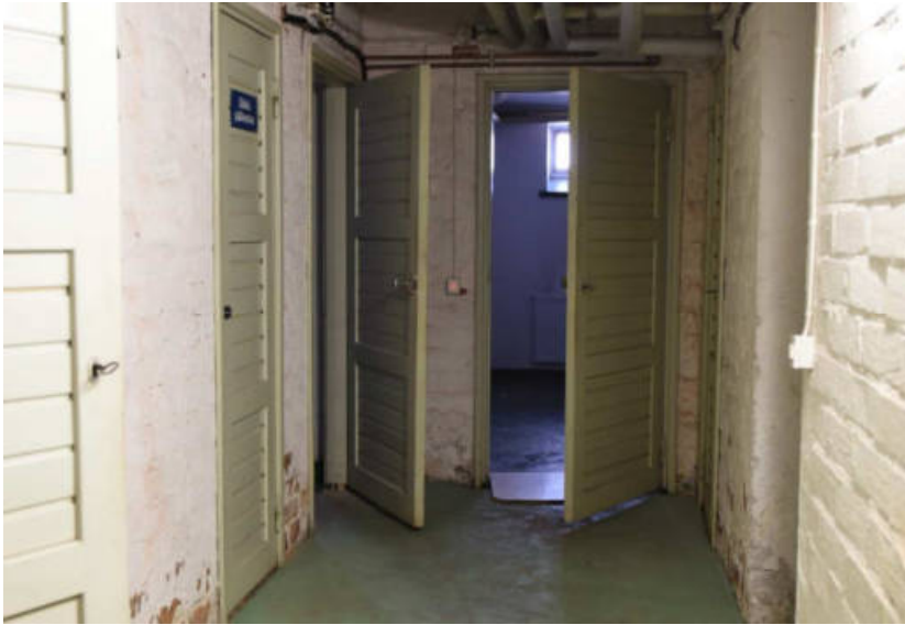
Kuva ylhäällä: Kellarikerroksen seinissä on tiiliverho. Ovet ovat vaakalaudoitettuja kehysovia.
