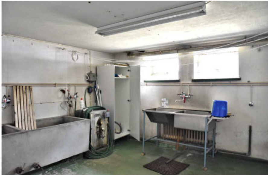
Kuva: Kellarikerroksen pesutupa. Kellarikerroksessa on jäljellä alkuperäisiä valurautaisia pylväsradiaattoreita.
