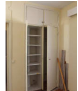
Kuva: Keittiökaapistot on uusittu. Vanhoja kiinteitä komeroita on edelleen jonkin verran jäljellä.
