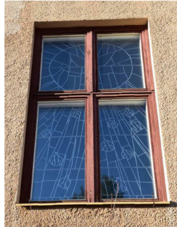
Kuva: Ristikarmi on peräisin 1980-luvun peruskorjauksesta. Alkuperäisissä kirkkosalin ikkunoissa oli vain vaakavälrikarmi ja sen molemmin puolin pystyvälipuitteet
