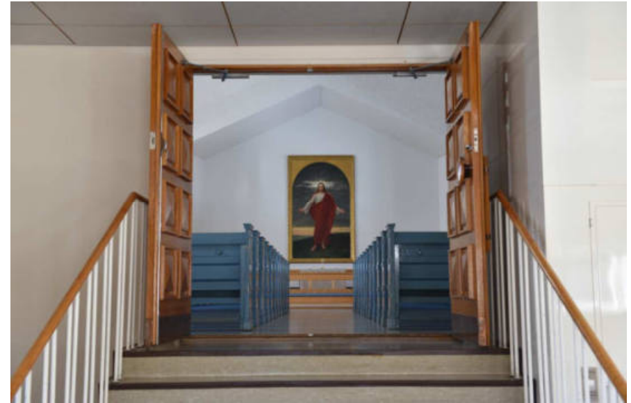
Kuva: Eteishallista kirkkosaliin nouseva porras ja jyrkät puuovet. Sisäportaitkojen käiteet ovat samaa mallia, mutta kirkkosaliin porraskäiteessä on metallipinnoja hieman tiheämmässä kuin muissa portaikoissa, aina kaksi jokaisen askelman kohdalla.
