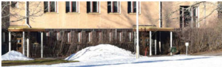
Kuva: 1980-luvulla rakennetut sisäänkäyntien katokset.
