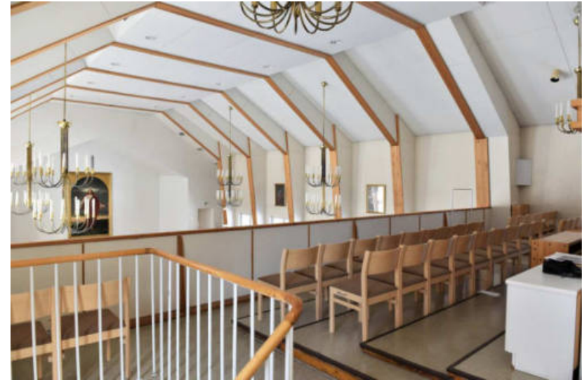
Kuva: Urkuparvi ja salin kehärunko. Alakatto lisätty 80-luvulla.
