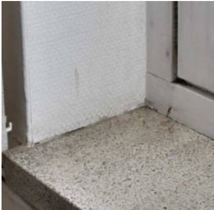
Kuva vasemmalla: Lasikuitutapettia ikkunan smyygissä. Ikkunapenkki mosaiikkibetonia.
