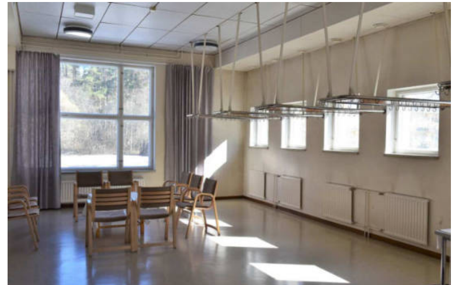
Kuva: Eteishallissa on alkuperäiset kattoon ripustetut metalliputki- ja puurakenteiset naulakot.
