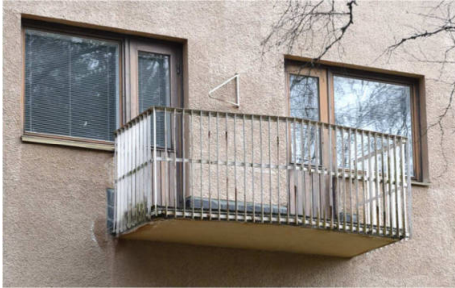
Kuva: Parveke. Asunnon ikkunat uusittu.
