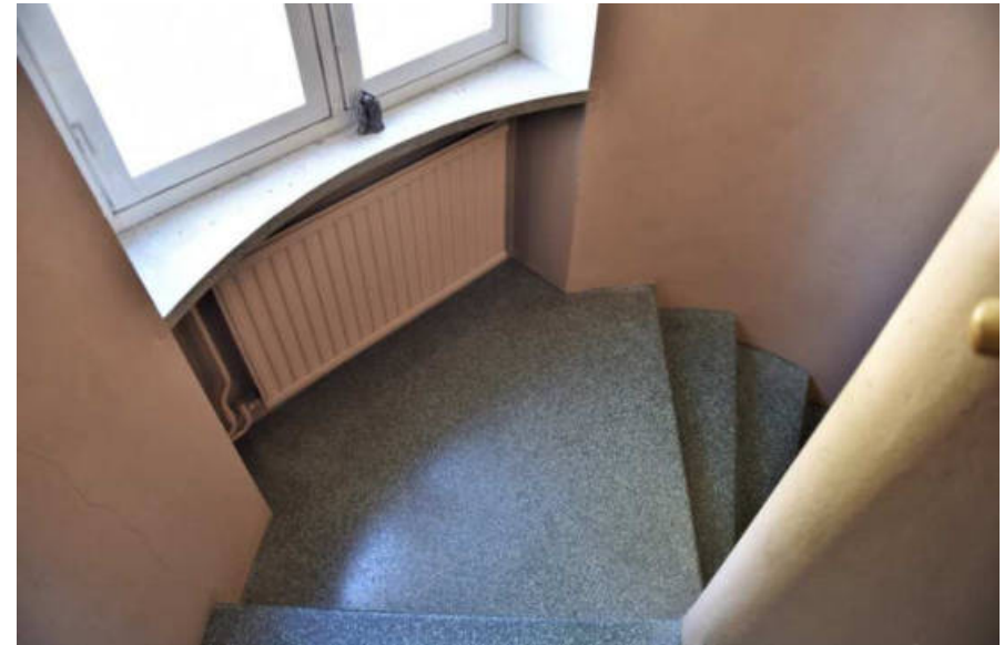
Kuva: Lepotasanne. Ikkunan mosaiikkibetoninen ikkunapenkki myötäilee tilan kaarevia muotoja.
