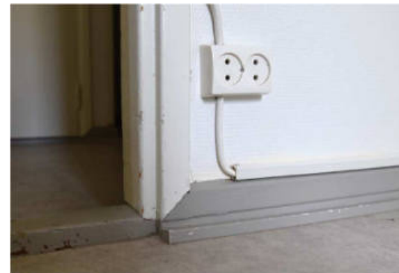
Kuva: Vanha lattialista, jossa syvennys mattolistalle. Puiset ovi- ja ikkunalistat ovat kapeita ja suoria.
