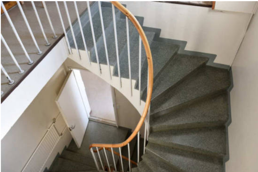
Kuva: Urkugarven nousevat kierreporras, alhaalla näkyy eteishalliin auki oleva ovi. Metallipinnat on kiinnitetty betoniaskelman sivuun,
